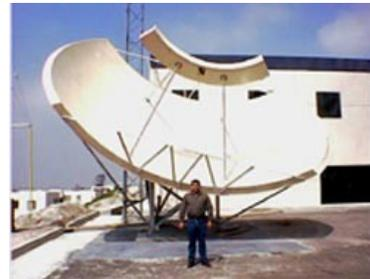
Antena Simulsat, recibe señal de 25 satélites simultáneamente
