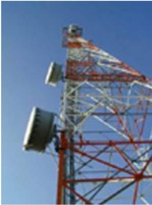
Un radioenlace terrestre o microondas terrestre provee conectividad entre dos sitios (estaciones terrenas) en línea de vista (Line-of-Sight, LOS) usando equipo de radio con frecuencias de portadora por encima de 1 GHz. La forma de onda emitida puede ser analógica (convencionalmente en FM) o digital.
